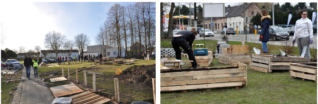
Figure 4 : illustrations durant la semaine de chantier
